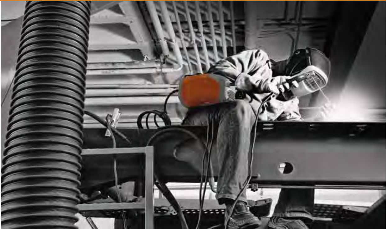
BOOSTER2 beim Einsatz im Stahlbau. Ultramobil, sichere Handhabung und volle Leistung.
